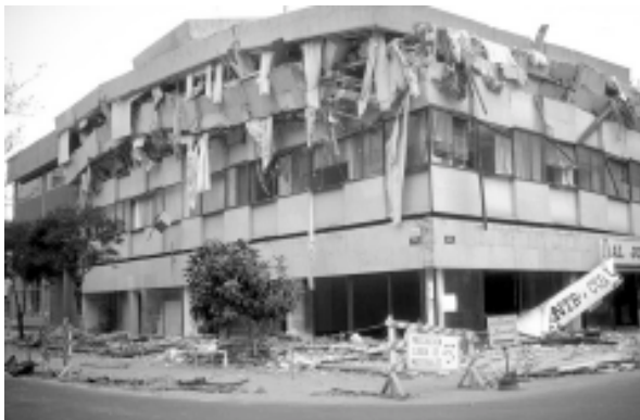
Figura 1. El sismo del 19 de septiembre de 1985, produjo el colapso parcial o total de edificios en la Ciudad de México
