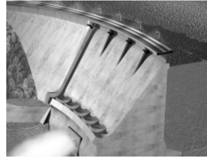
Figura 38. Algunas instalaciones cuentan con redes locales de observación sísmica como lo son presas
