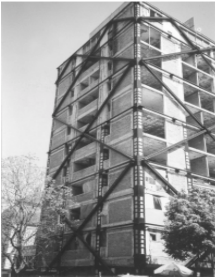
Figura 42. Rehabilitación sísmica en un edificio de la Ciudad de México. Para estudiar su comportamiento se instalaron acelerógrafos en sus diferentes niveles
