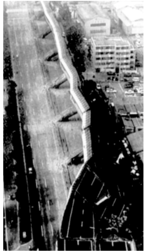
Figura 21. Colapso lateral del viaducto Hanshin, Japón, 1995
