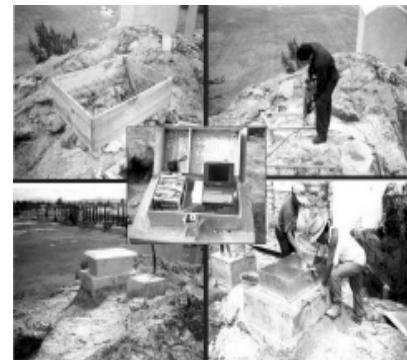
Figura 39. Estación acelerográfica Zaragoza en la Ciudad de México
