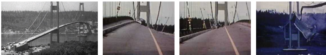
Figura 12.1: El puente de Tacoma se destruyó por vibraciones autoexcitadas inducidas por fuertes vientos.
