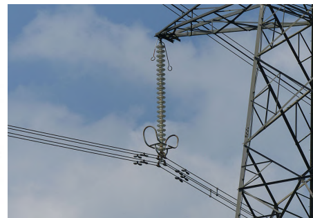
Figura 13.15: Concepto de vibración amortiguada vs autoexcitada (izq.). Aisladores Stockbridge para tendidos eléctricos (der.)
