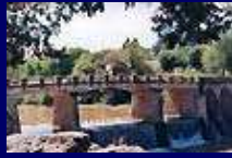
Puente - La Falda - Córdoba
